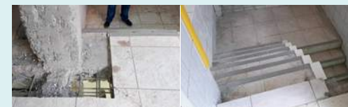
（圖 1）及（圖 2）為宿舍樓梯整修前與整修後之比較圖。
